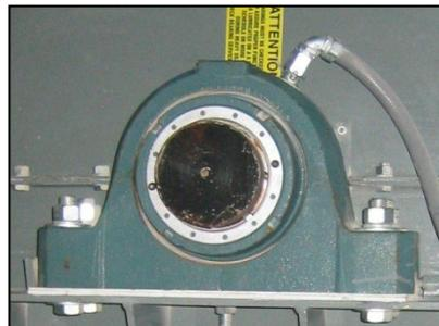
Capteur installé sur le roulement du convoyeur
