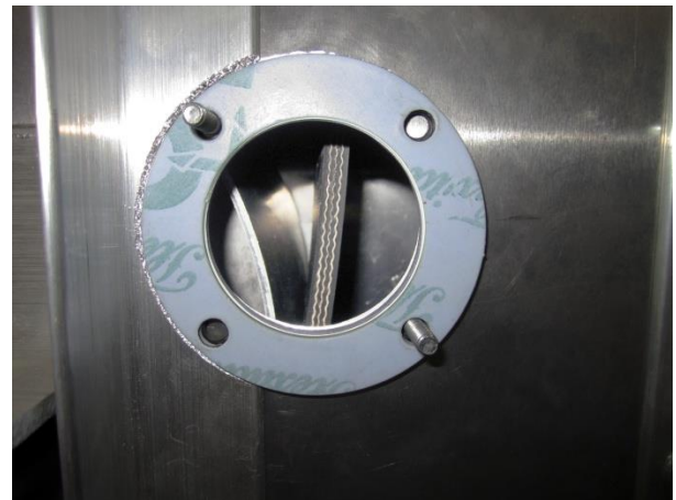
Figura 1 – Gaură de montare a TouchSwitch
