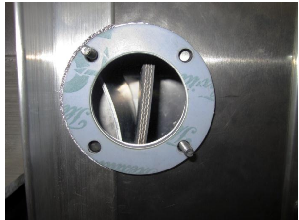
Afb. 1 – Montagegat voor TouchSwitch
