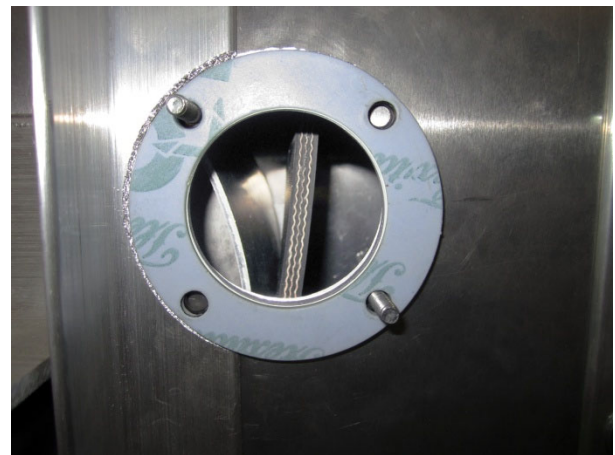
Abbildung 1 – TouchSwitch™ Montageloch
